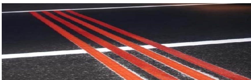
Рисунок 16. Устройство шумовой полосы путем наклейки на покрытие поперечных линий из пластичных материалов
