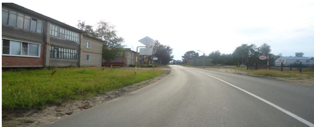
Рисунок 13. Улица Новая. Отсутствие бордюрного камня, водоотвода с поверхности проезжей части, тротуара.
