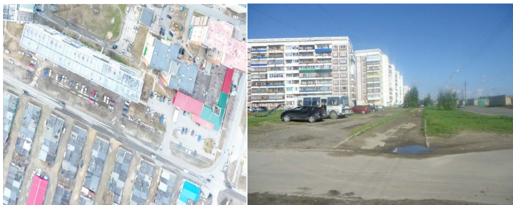
Рисунок 9. Северо-Восточный проезд. Отсутствие тротуаров и бордюрного камня. Отсутствие водоотвода с территории гаражных боксов.
