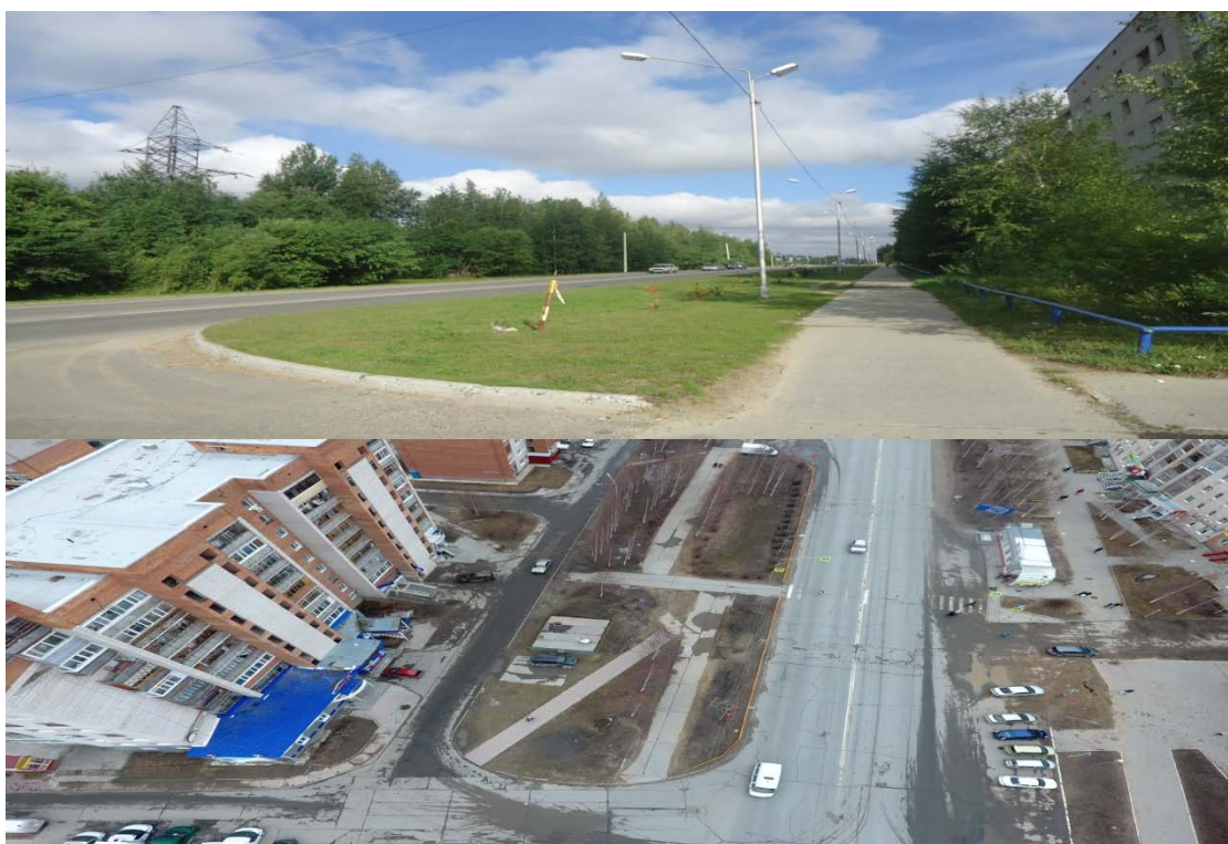
Рисунок 11. Улица Строителей. Наблюдается износ покрытия дорог и тротуаров. Требуется обустройство остановок общественного транспорта. Наблюдается износ бортовых камней, отсутствуют тротуары и линия освещения на участке улицы от ул.Промышленной до ул.Транспортной.
