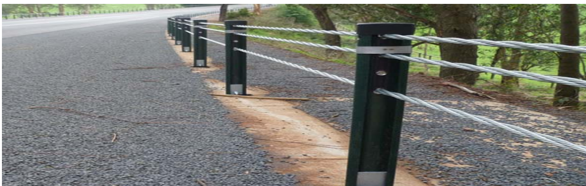
Рисунок 18. Пример установки тросового ограждения на обочине (применения на дорогах общего пользования)
